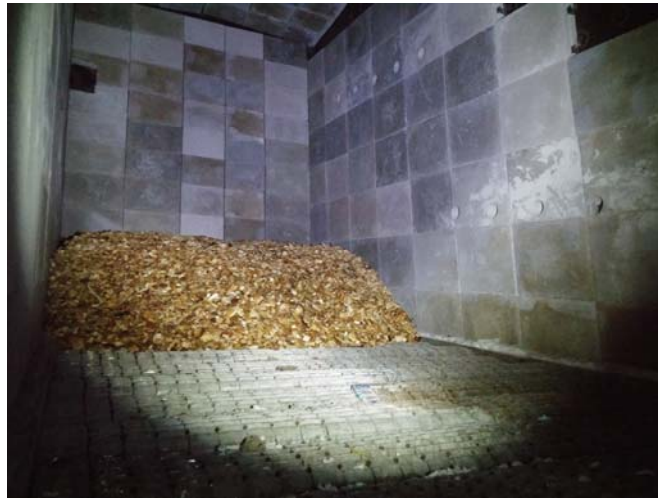
Ensimmäinen erä haketta valmiina sytytykseen kattilan arinalla
